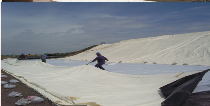
Reactor BVF colocacion de Membranas Flotantes
