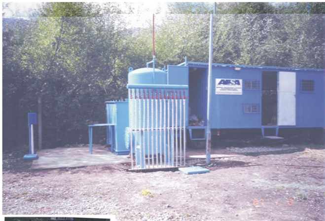
Vista del equipo tratador de los líquidos provenientes de la napa freática y tratamiento de los efluentes industriales de la planta
