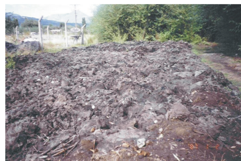
Tratamiento de 182 m3 de suelos contaminados, con incorporación de 250 m3 de suelos no contaminados
