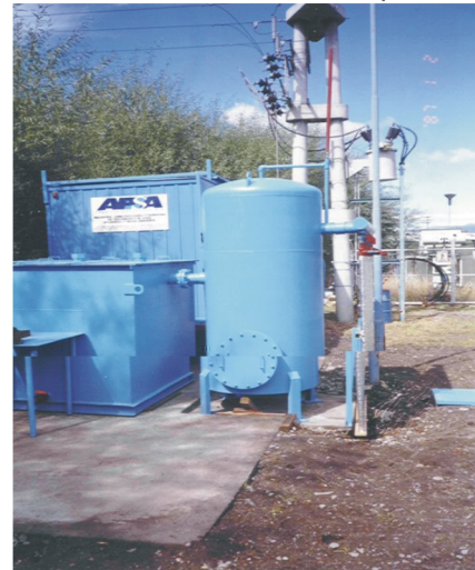
Vista del equipo tratador de los líquidos provenientes de la napa freática y tratamiento de los efluentes industriales de la planta
