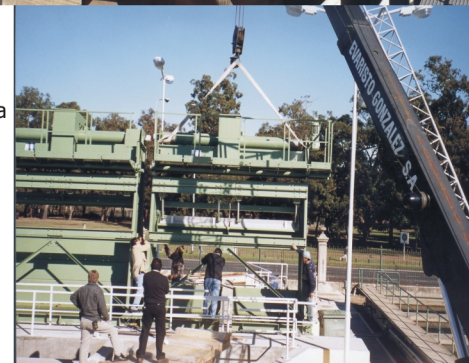
Vista del montaje de las Rejas
